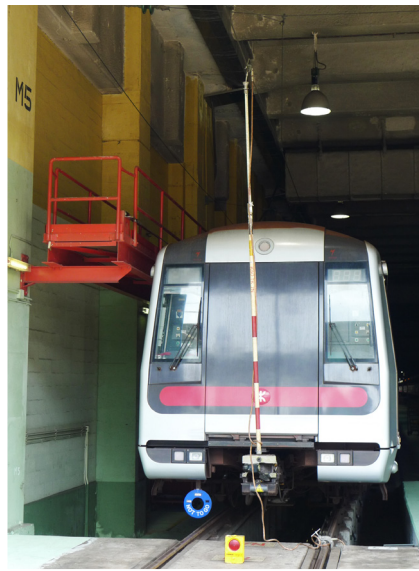
所有相關的工序都妥為聯鎖，杜絕了人為出錯，可更安全有效率地完成的工作 Proper interlocking helps prevent human errors and enables safer and more efficient work
